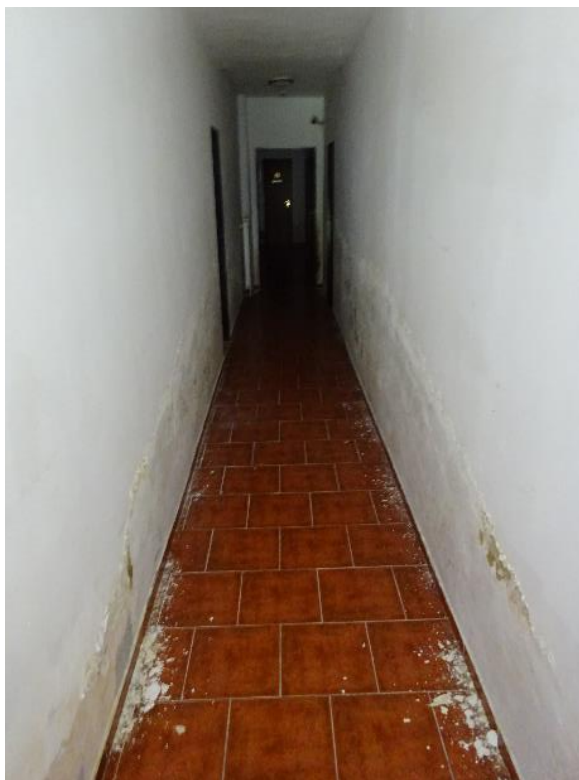
Obrázek 7 - Chodba v zařízení
